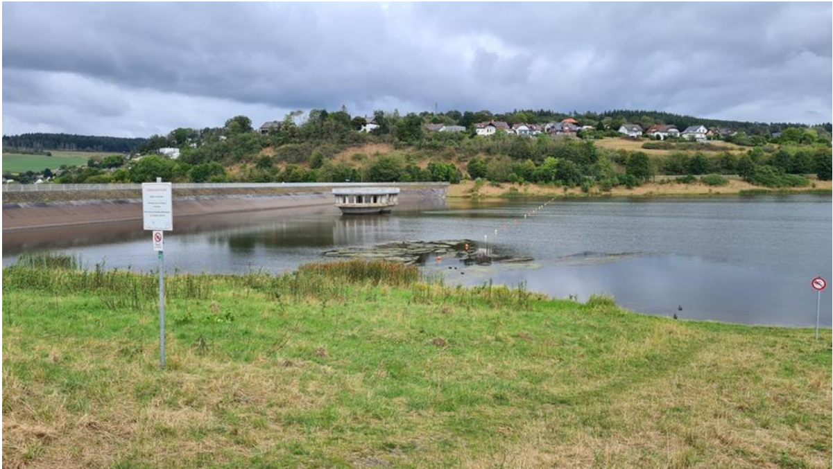
Ansicht 26: Aartalsperre, Hochwasserentlastungseinrichtung, eigene Aufnahme, 14. September 2024
