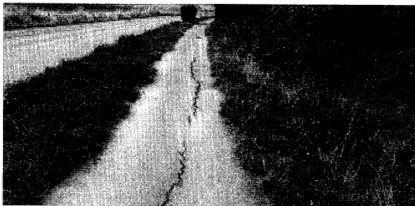
Abb. 2: südlicher Abschnitt in Dammlage
