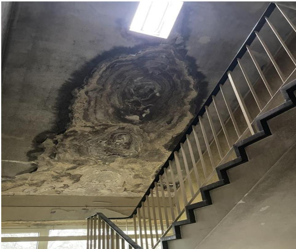
2. Sanierung des Deckenputzes der kompletten OG Decke, sowie Malerarbeiten in allen Räumen und Fluren.
