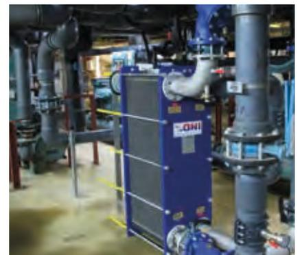
Beste Maßnahme (Plattenwärmetauscher)
