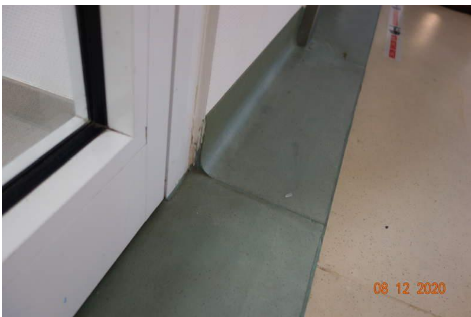
Abbildung 24 Sanierungsbedarf Bodenbelag
