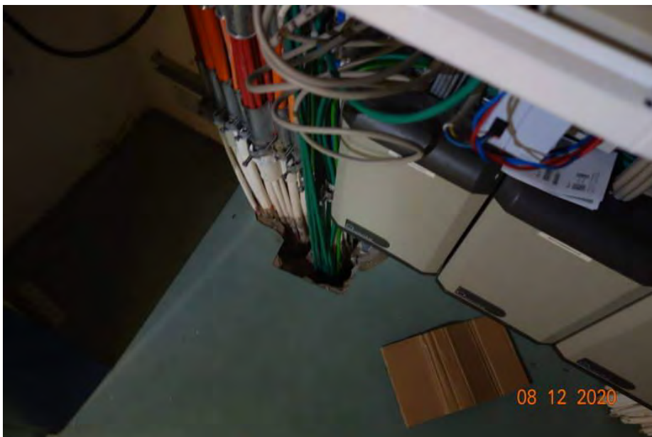
Abbildung 29: Offene Deckendurchbrüche
