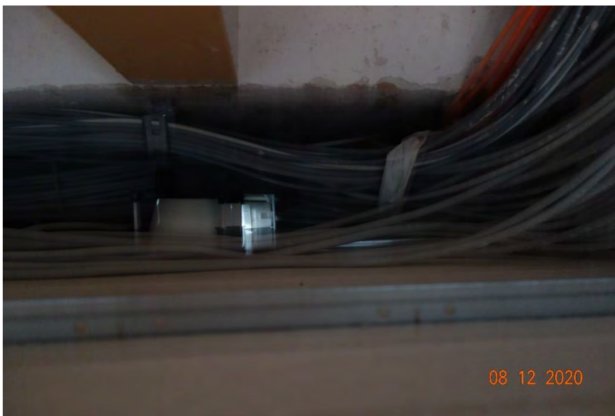
Abbildung 18: Hohlraum über Fertignasszelle
