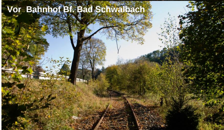
Einfahrt Bahnhof Bf. Bad Schwalbach
