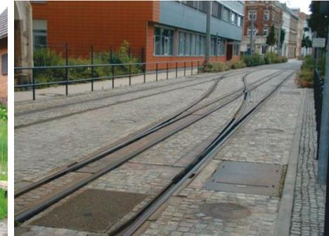
Dreischienengleis in Zwickau (Nutzung Straßenbahn (Meterspur) und Bahn (Normalspur))
