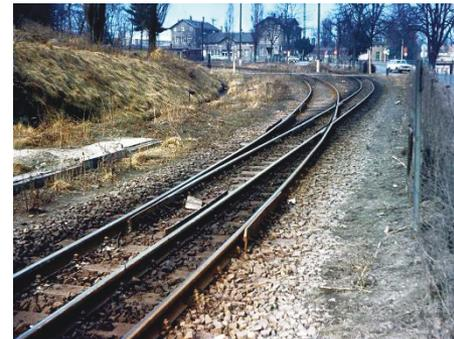
Herausschwenken des Normalspurgleises aus dem Bahnsteig heraus, der in Schmalspur angefahren wird. (Oschatz)
