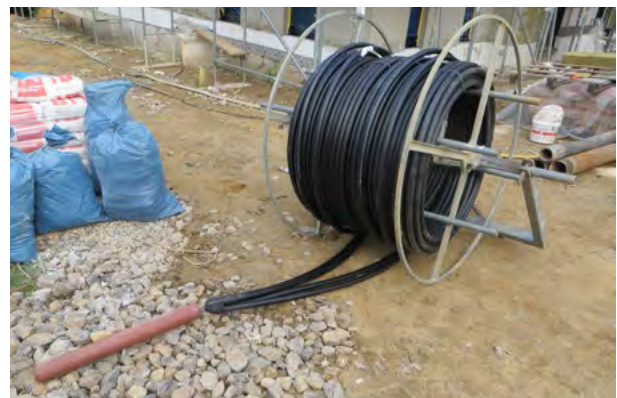
Abb. 3: Erdwärmesonde mit Gewicht vor Einbau in das Bohrloch.
