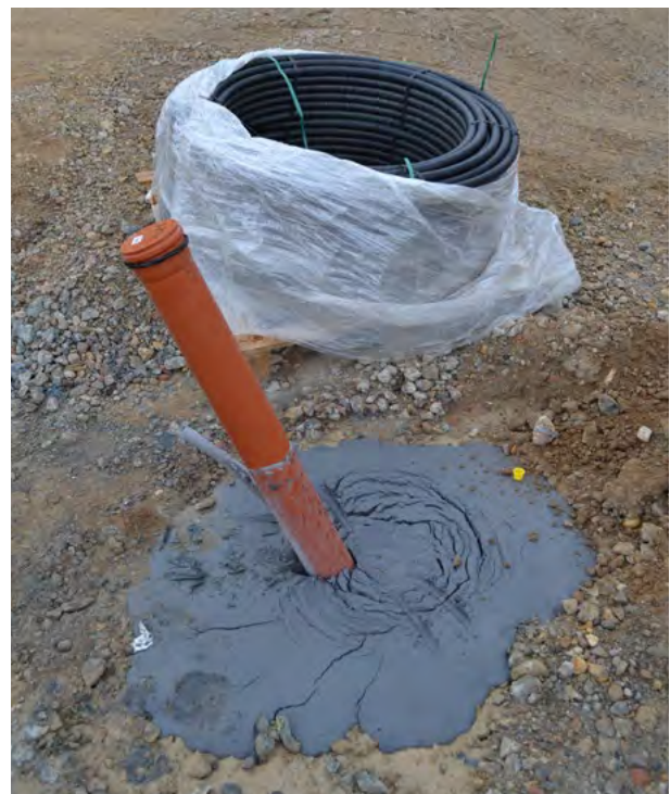
Abb. 9: Verpresste Sondenbohrung.
