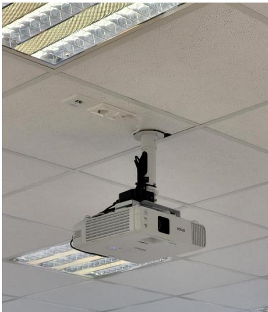
*Abbildung 5 Deckenbeamer*
