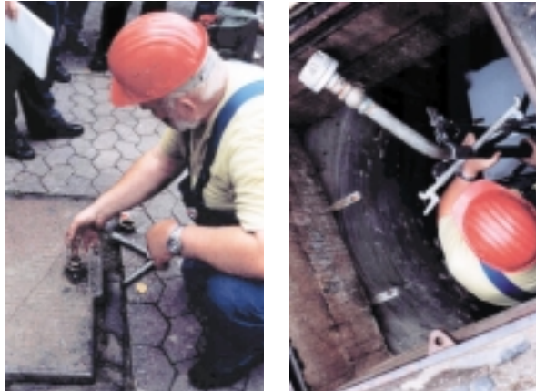
Einstieg in einen Brunnenschacht zur Kontrolle oder zur Vorbereitungen der Wasserförderung
