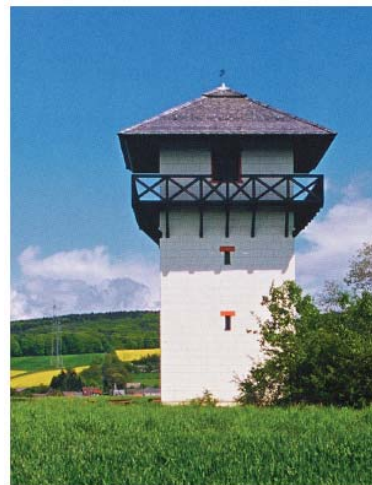
Rekonstruktion eines Wachturmes bei Idstein-Dasbach *)
